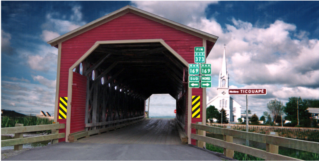
Pont de Ticouapé ( 1905-1965)
